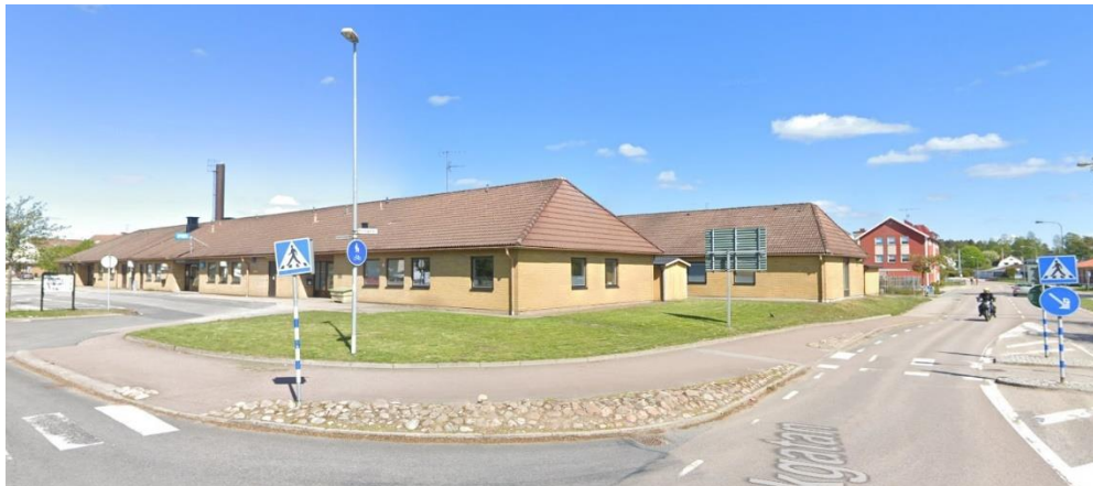
Bild 2. Befintlig vårdcentralbyggnad från korsningen Centrumgatan – Parkgatan.
