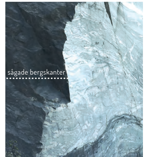
Det norra brofästet skapar en ny siktlinje från Grangatan och ut över Kyllingsån. Trappa och gångväg skär genom berget som förses med sågade kanter och kontrasterar mot omgivande granskog. Bergskärningen blir ett intresseväckande och inbjudande motiv från Grangatan.
