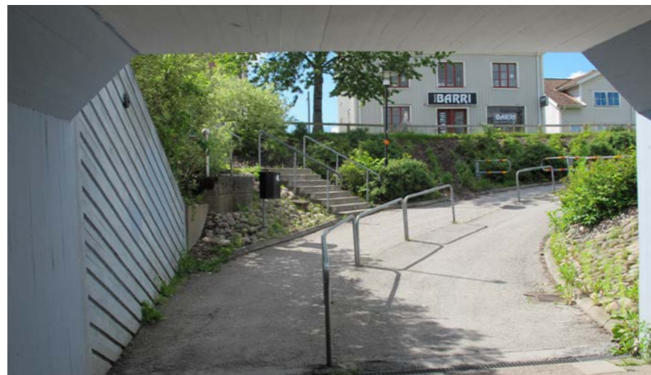
(8) Branta slänter mot gångtunneln på södra sidan.
