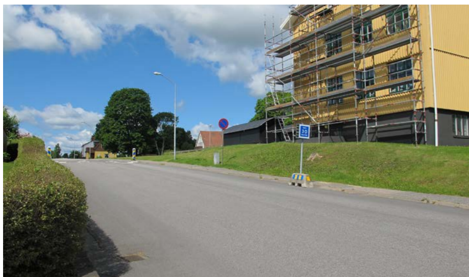
(3) Kempegatan sluttar uppåt förbi den gamla skolbyggnaden.
