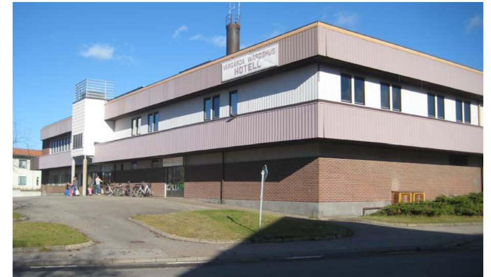
(2) Västra fasaden med entréer till simhall och gym
