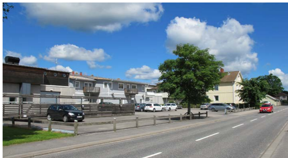
(3) Bostäder och handelsbyggnader mot Kungsgatan vänder baksidan mot Centrumgatan
