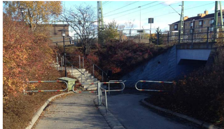
(3) Brant nerfart mot gångtunneln med hinder för att undvika kollision
