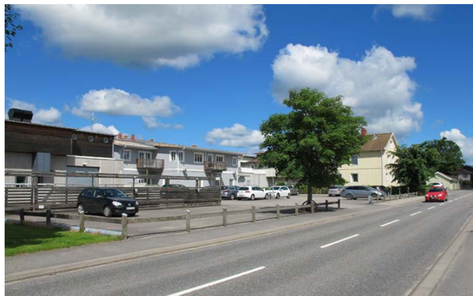
Parkering ut mot Centrumgatan, Urmakaren 1-6.
