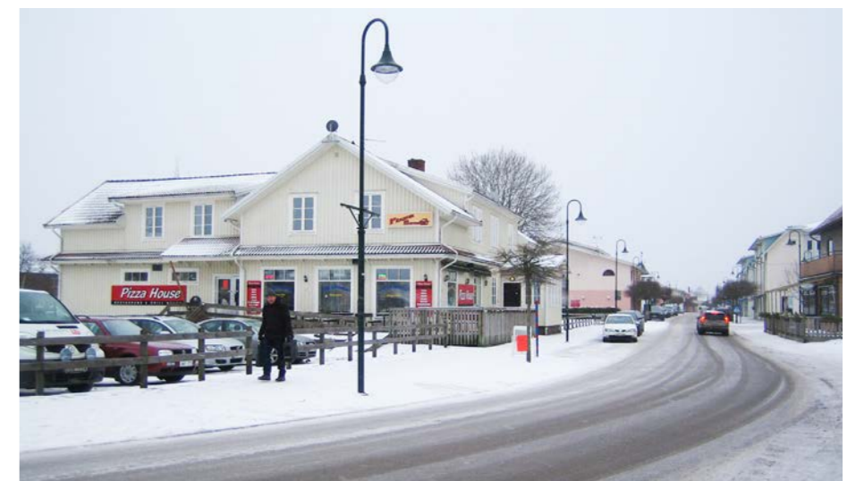
(3) Kv Muraren mot Kungsgatan, äldre byggnad med verksamheter och bostäder.
