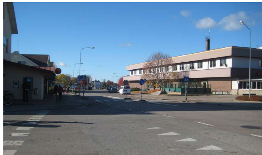
(3) Fasaden ut mot Parkgatan
