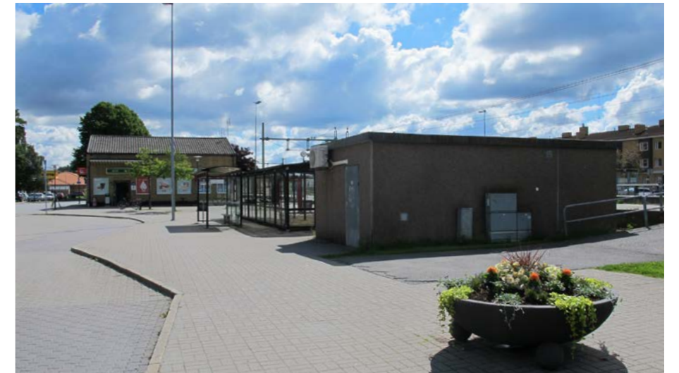
(2) Cykelhuset och teknikbyggnaden skärmar stationshuset från gångtunneln.
