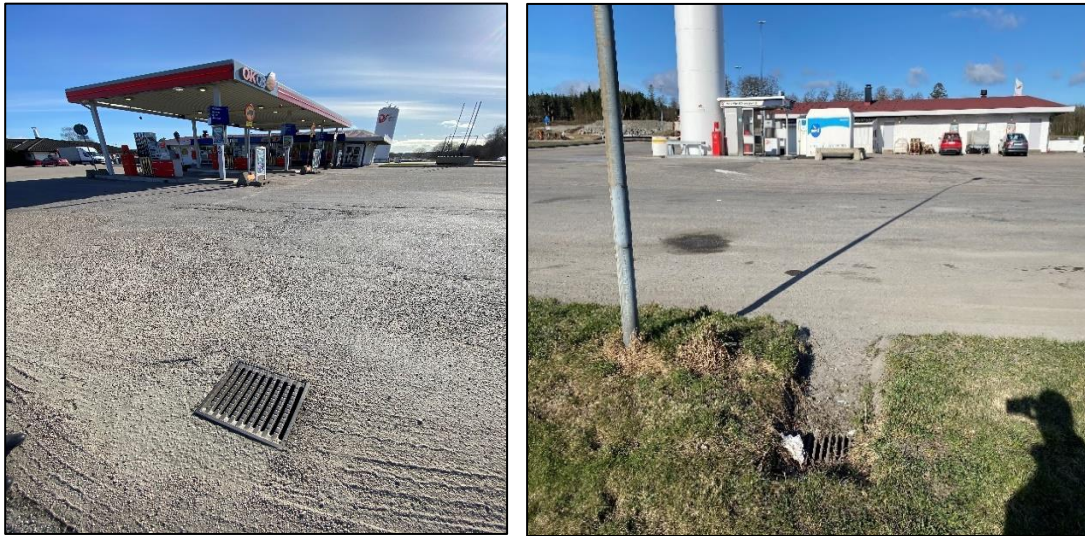
Figur 8. Brunnar som samlar dagvatten vid bensinstation
