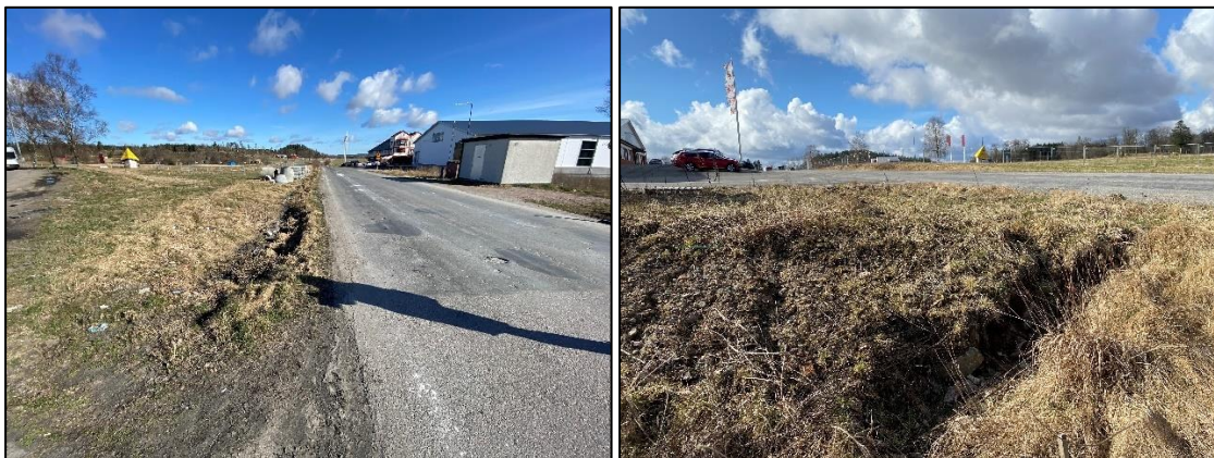
Figur 11. Dagvatten hanteras genom vägdiken norrut
