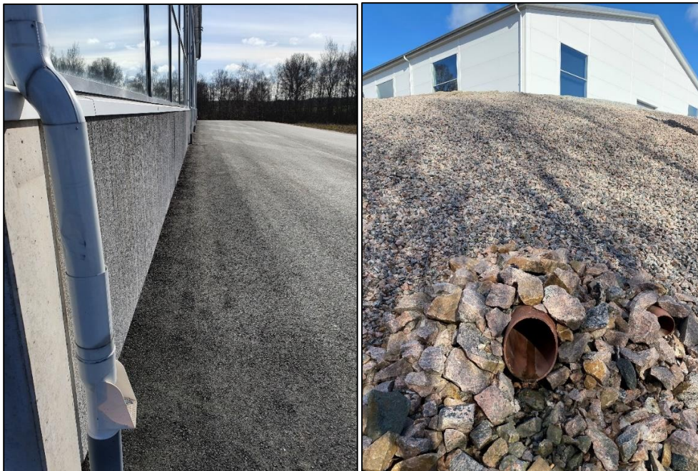
Figur 9. Dagvatten hanteras i ledningsnät och avleds till bäcken vid fastighet Lund 3:16.
