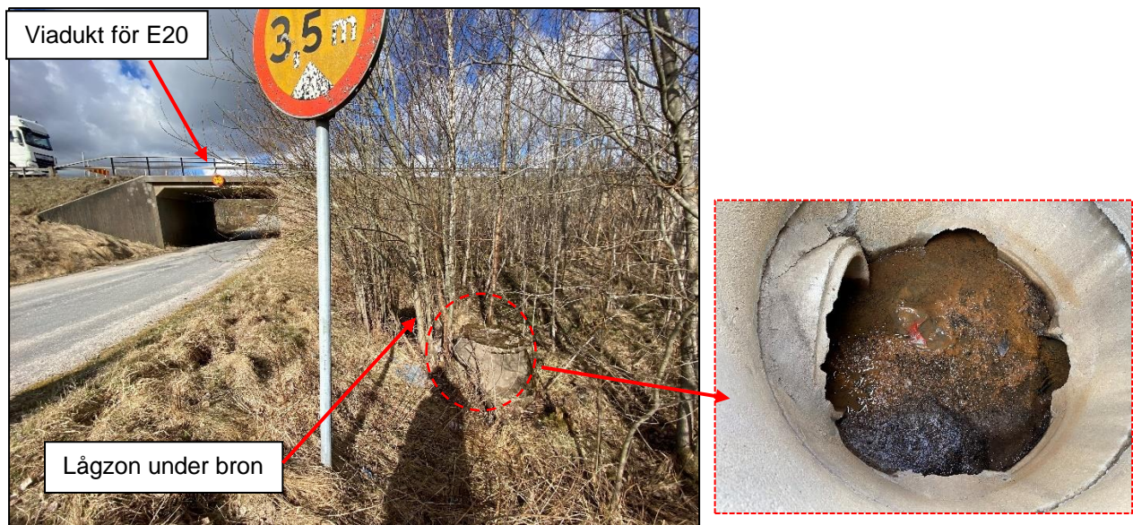
Figur 13. Viadukt för E20 och lågzon under bron
