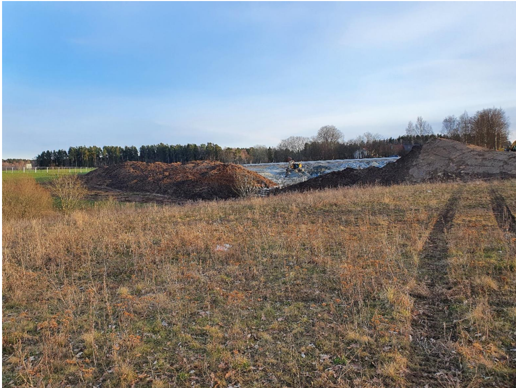
Figur 9 Schakt för vägbygge i korsning väg 181 / E20.
