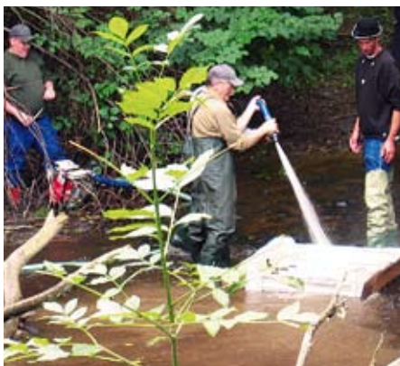
Figur 49. Genom att successivt gräva upp botten substratet på sållramen kunde det spolas rent från fina sediment. Åtgärden utfördes för att skapa lämpliga bottenar för unga flodpärlmusslor i Life-vattendraget Bratteforsån. Foto: Sofi Alexanderson
