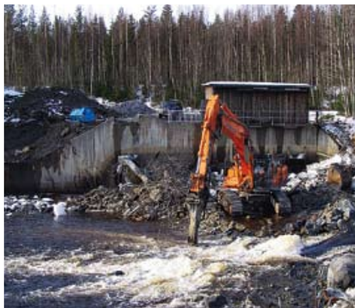
Figur 51. Utrivning av Kubadammen i Nätraån. I vattendraget förekommer ett gles bestånd av flodpärlmusslor. Foto: Håkan Söderberg
