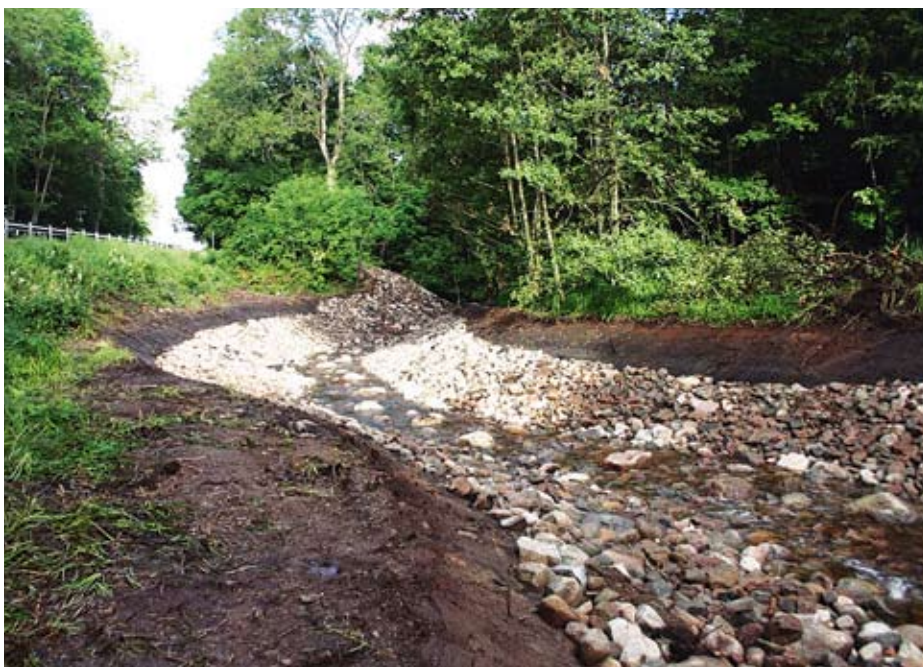
Figur 52. En fåra har skapats genom de gamla sedimentlagren i dammens botten. Sedimenten stabiliseras, liksom fåran. Snart kommer vegetation att täcka sedimenten som därvid stabiliseras ytterligare. Foto: Erik Degerman
