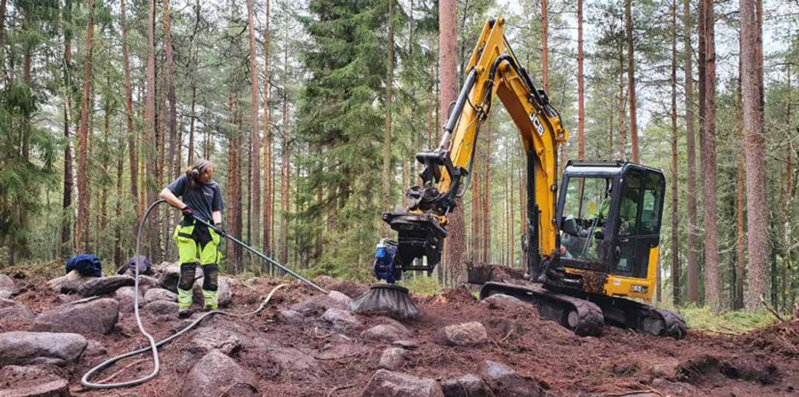
Figur 5. Grävmaskin med rotorborste och handhållen tryckluft för att på ett effektivt sätt avlägsna växtligheten. Foto Mats Hellgren.
