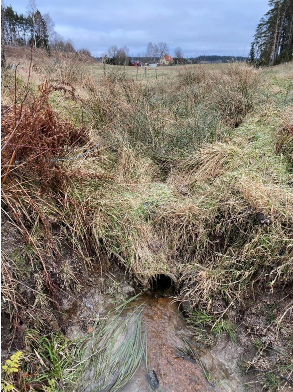
Figur 8. Norra diket som mynnar i ledning ca 200 m norr om plangräns i nordväst.
