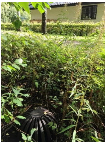
Figur 7. Befintlig kupolbrunn i södra lågzon. Korsnäbbsgatan 12 i bakgrunden.
