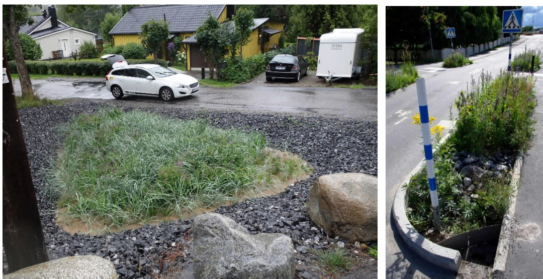
Figur 40. Exempel på nedsänkta växtbäddar. Bildkällor: VegTech AB samt Dagvattenguiden.se
