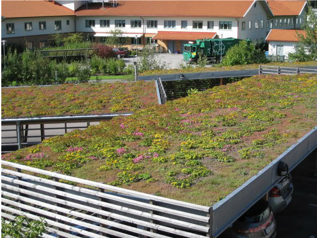
Figur 42. Grönt sedumtak på garagebyggnad i Kungsbacka. Bildkälla: VegTech AB.
