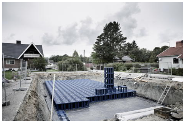
Figur 35. Körbar dagvattenkassett samt anläggande av kassettsystem. Bildkälla: Wavin.se
