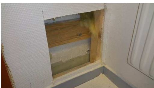
Bild 2: Generell ytterväggskonstruktion i större delen av byggnaden.
