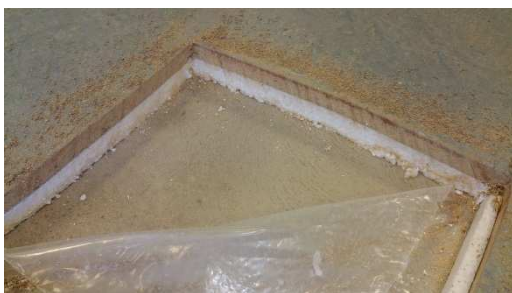
Bild 1: Generell golvkonstruktion i större delen av byggnaden.
