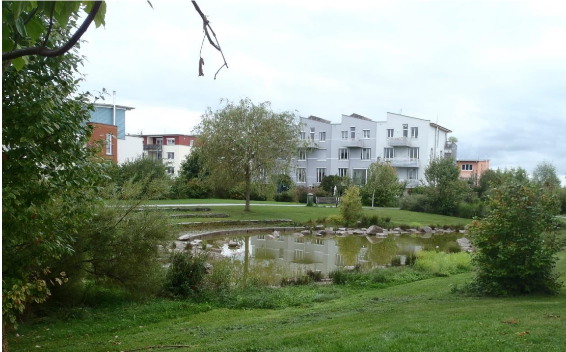
Figur 4. Öppet födröjningsmagasin i form av en dagvattendamm med permanent vattenyta i ett bostadsområde i Tyskland. Foto: Ramböll
