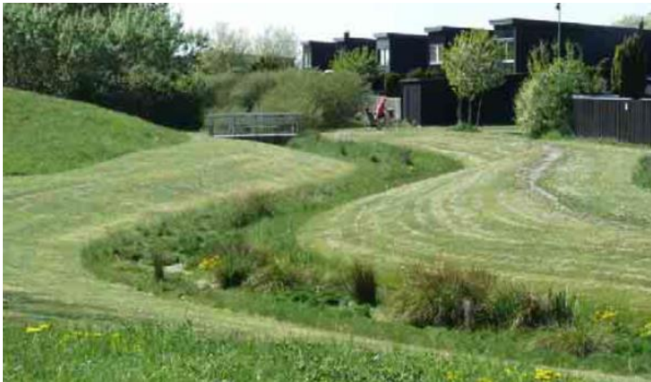
Figur 12. Svackdiken i Fjärilsparken, Malmö. Källa: VA SYD.
