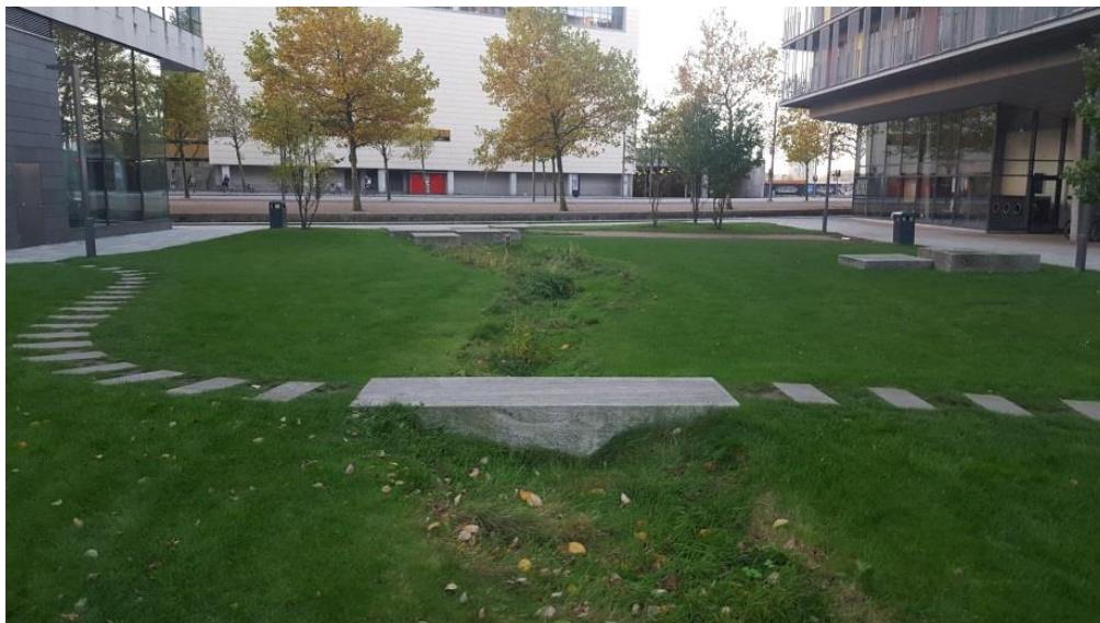
Figur 12. Exempelbild på ett mjukt skålat makadamdike i Köpenhamn. Foto: Ramböll
