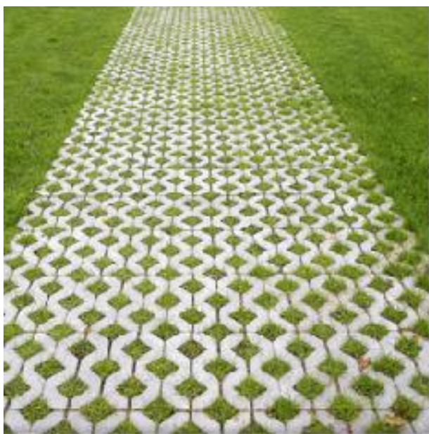
Figur 10. Hålsten av betong som bildar en stabil och genomsläpplig yta Källa: Utemiljö & Stenprodukter i Skåne AB 2012.
