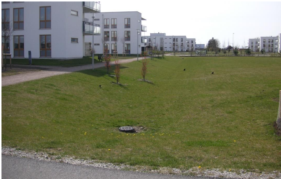
Figur 7. Översilningsyta i Malmö. Foto: Ramböll
