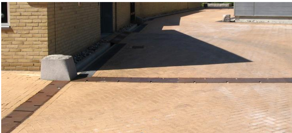
Figur 22 Exempel på körbara plattor i Västra Hamnen i Malmö.
