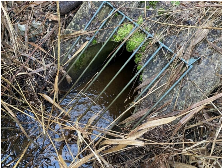
Figur 17. Inlopp till befintlig dagvattenledning som ansluter till Sävån
